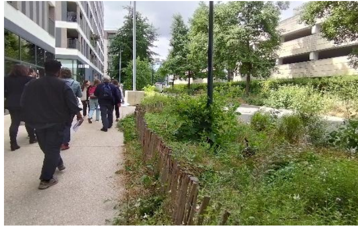
Ouvrages de gestion des eaux pluviales À Est Ensemble
