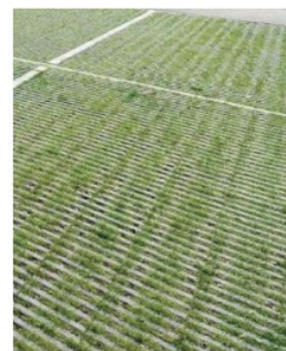
dalles béton engazonnées parking
