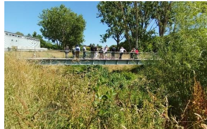
Réouverture de cours d'eau Le Petit Rosne à Ezanville
