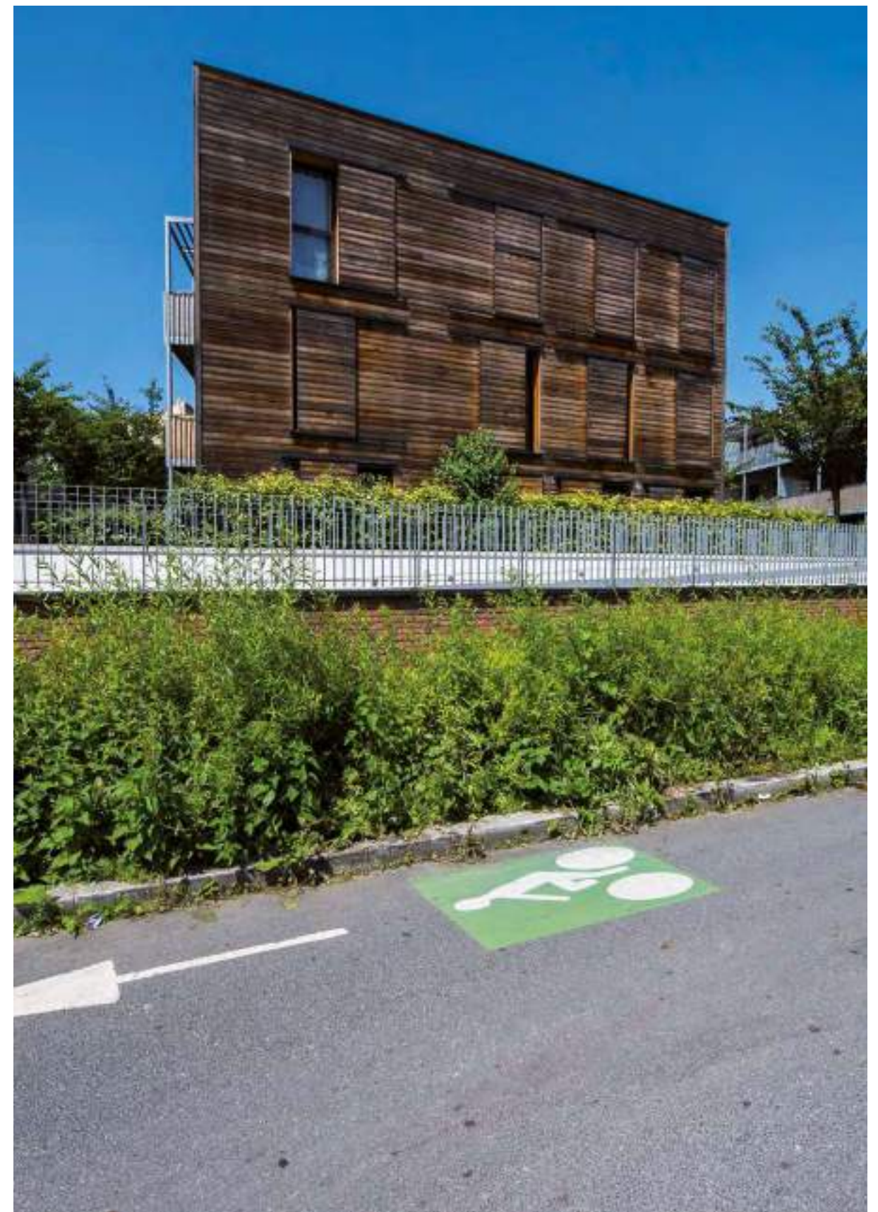
RUE DE YÉLIMANÉ, MONTREUIL Noe assurant l'infiltration des eaux pluviales de la voie publique.
