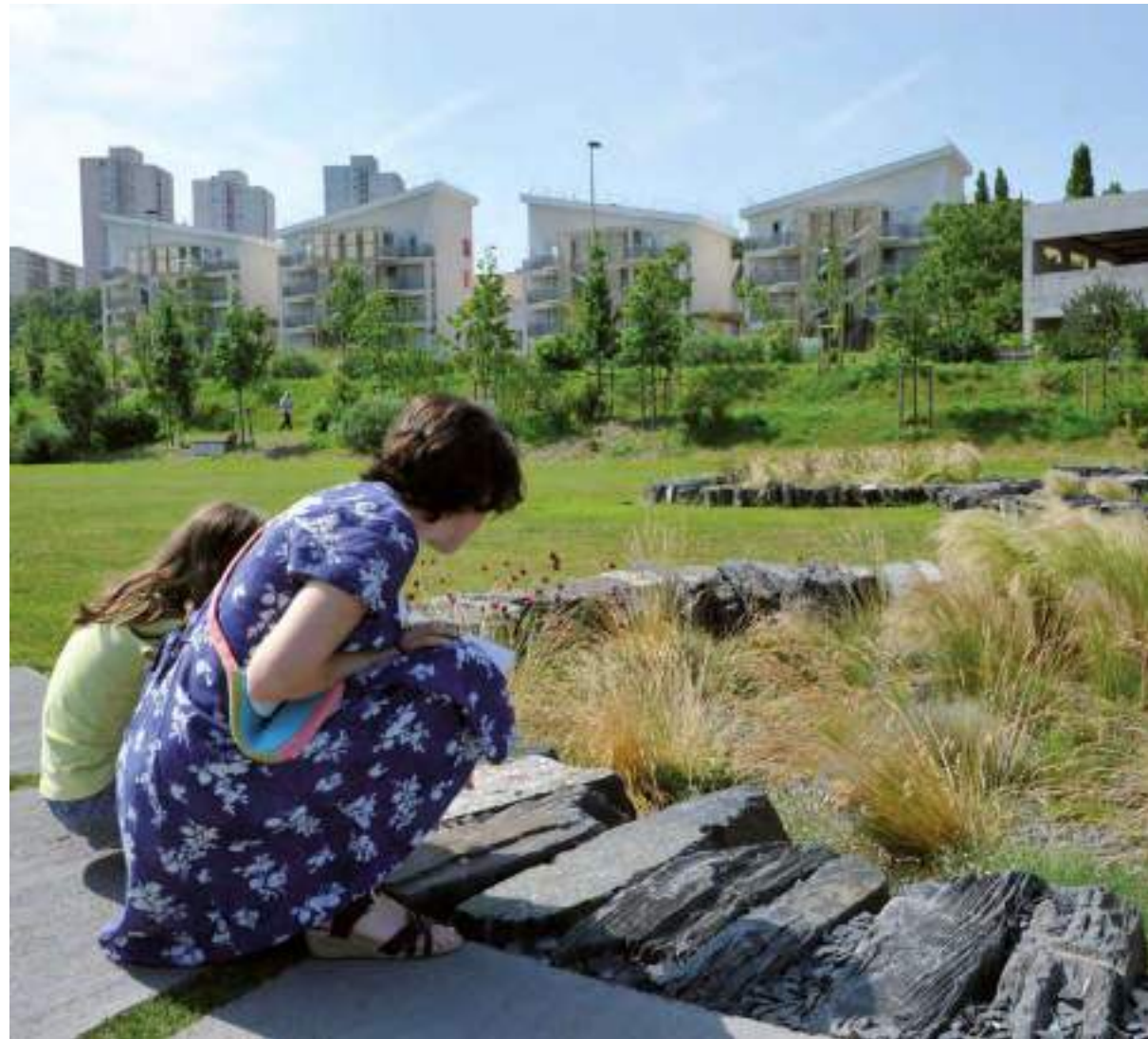
PARC DES GUILLAUMES, NOISY-LE-SEC Filtre assurant une dépollution des eaux pluviales.
