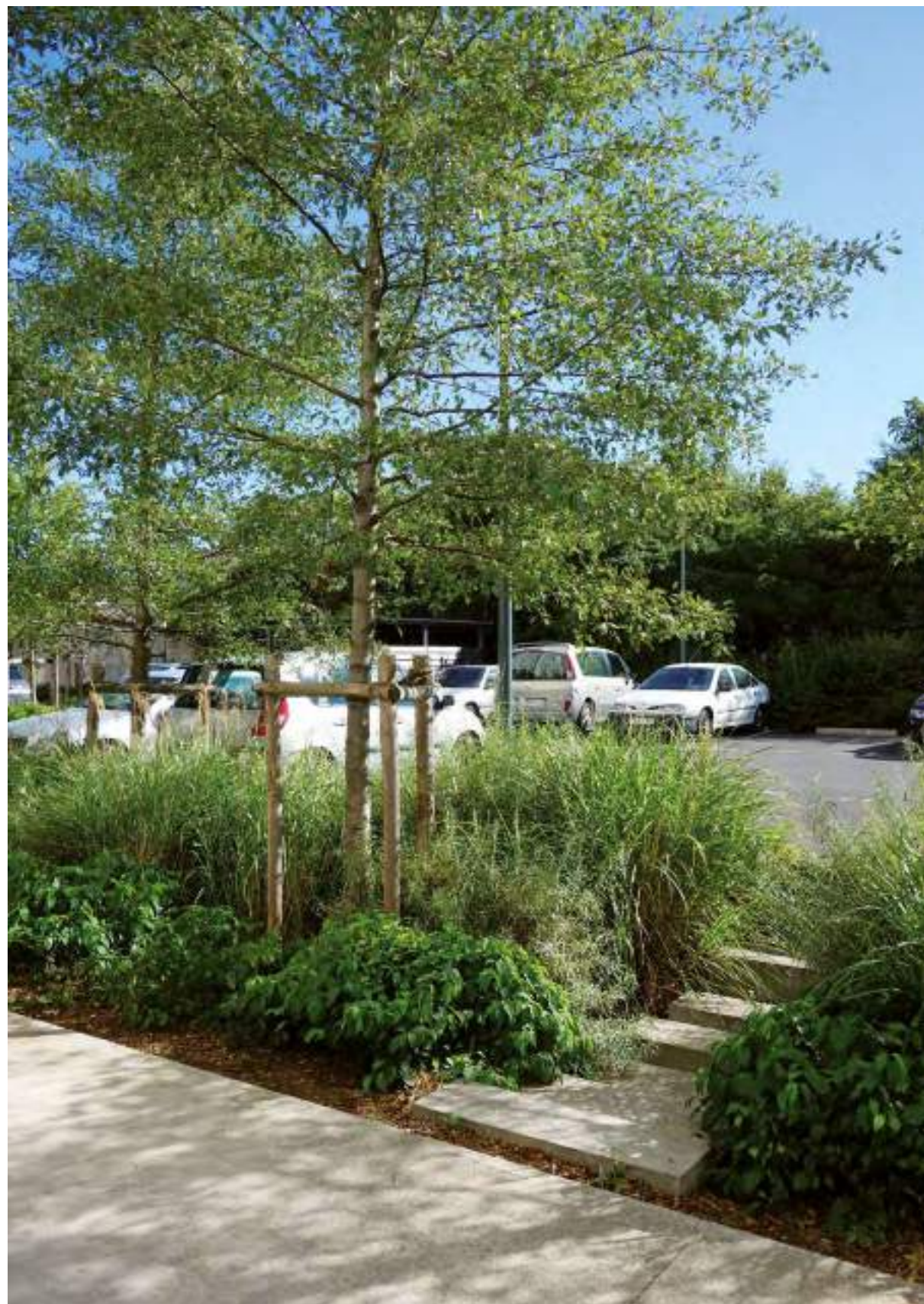
QUARTIER DU BEL-AIR, MONTREUIL Gestion intégrée des eaux pluviales en cœur d'îlot.
