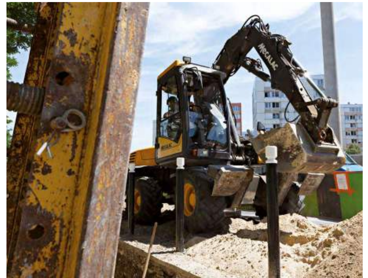
TRAVAUX DE TERRASSEMENT POUR LA POSE DE CANALISATIONS D'ASSAINISSEMENT
