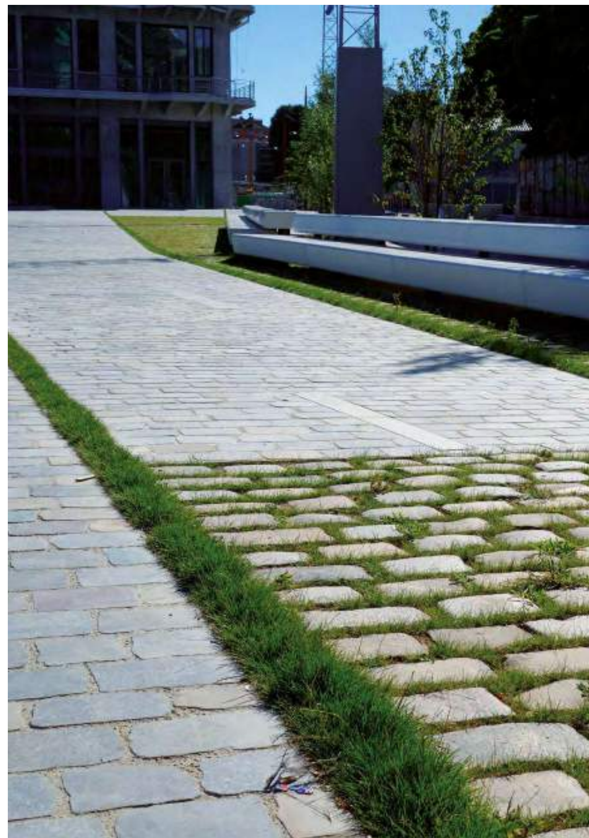
PLACE DE LA POINTE, PANTIN « Filets verts » et pavés enherbés permettant de limiter le ruissellement et la vitesse de l'écoulement.
