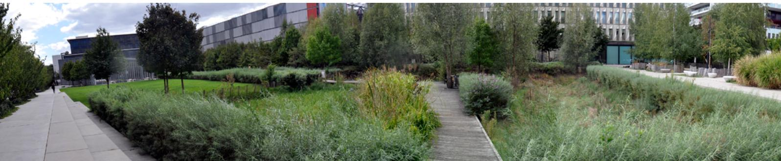
Le public est mis à distance de l'espace dédié à la gestion des eaux pluviales par l'aménagement d'un ponton et de gradines réservés au cheminement et au repos, Bassin végétalisé du Parc du temps des Cerises à Saint-Denis (93), Montage de photos Complémenterre
