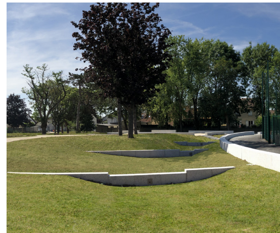
Emprises multifonctionnelles, surverses, chemins d'eau de pluie, dispositifs de micro-stockages, topographie artificielle associée (creux, vallonements, pentes...), noues
