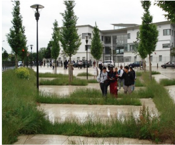
Emprises multifonctionnelles, surverses, chemins d'eau de pluie, dispositifs de micro-stockages, topographie artificielle associée (creux, vallonements, pentes...), noues
