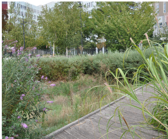
Dispositifs de micro-stockages, topographie artificielle associée (creux, vallonements, pentes...), noues
