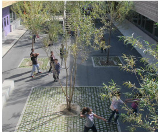
Emprises multifonctionnelles, surverses, chemins d'eau de pluie, dispositifs de micro-stockages, topographie artificielle associée (creux, vallonements, pentes...), noues
