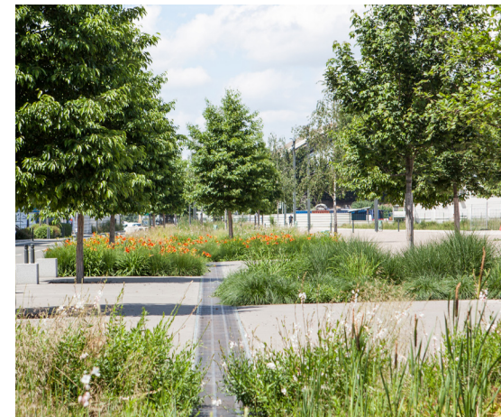
Emprises multifonctionnelles, surverses, chemins d'eau de pluie, dispositifs de micro-stockages, topographie artificielle associée (creux, vallonements, pentes...), noues
