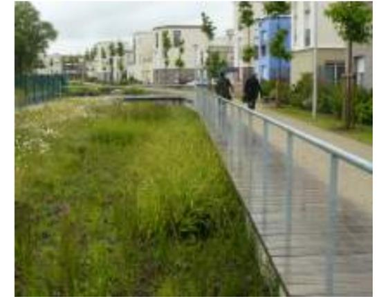
*Emprises multifonctionnelles, surverses, chemins d'eau de pluie, dispositifs de micro-stockages, topographie artificielle associée (creux, vallonements, pentes...), noues*
