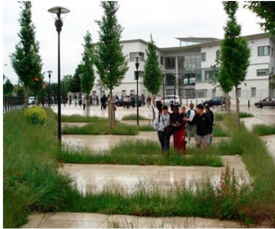
Emprises multifonctionnelles, surverses, chemins d'eau de pluie, dispositifs de micro-stockages temporaires, topographie artificielle associée (creux, vallonements, pentes...), noues
