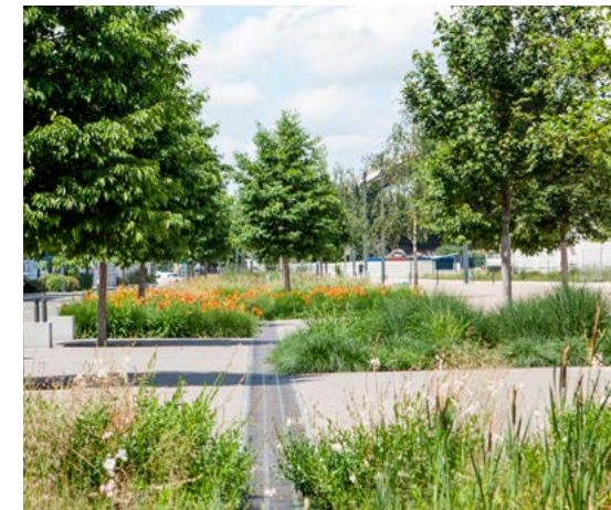
Emprises multifonctionnelles, surverses, chemins d'eau de pluie, dispositifs de micro-stockages temporaires, topographie artificielle associée (creux, vallonements, pentes...), noues
