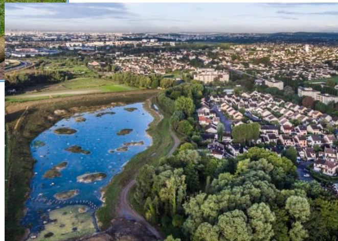
Zone d'expansion de crue sur le Croult, Gonesse – 2019 (©SIAH)
