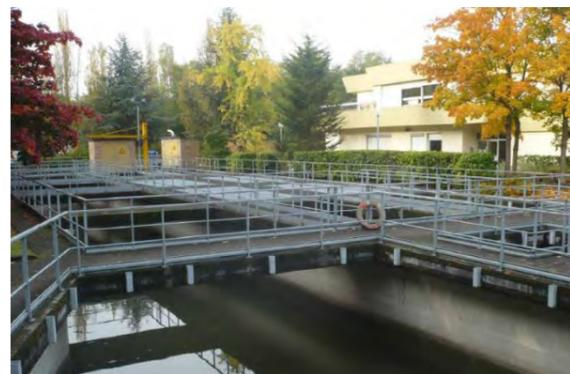
Figure 24 : CTR - vue sur les chambres à sable
