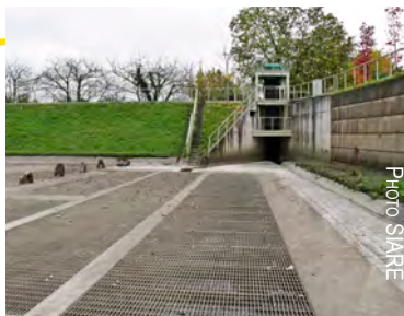
Bassin de Groslay amont - SIARE
