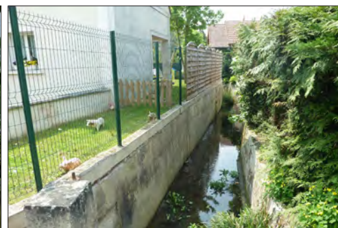
Vue discrète sur le ruisseau lors de son passage en fond de jardin depuis une rue, Margency
