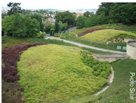
Aménagement paysager des réservoirs enterrés de Montmorency (ouvrage du SEDIF)
