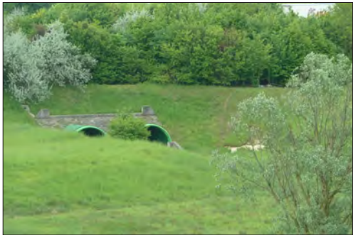
Aux abords de la Francilienne, le ru est moins visible et moins accessible. Il est surtout perceptible via la topographie de sa vallée et les ouvrages de franchissement sous la Francilienne
