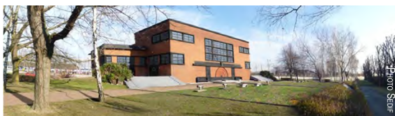
L'usine à puits de Pantin, inscrite à l'inventaire supplémentaire des Monuments Historiques (ouvrage du SEDIF)
