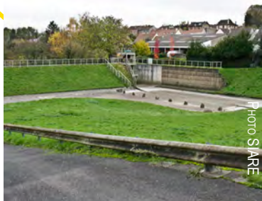
Bassin de Groslay amont - SIARE
