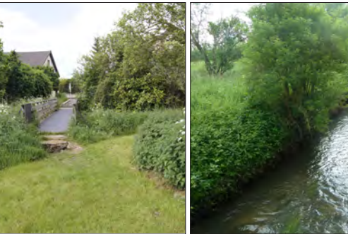
Aménagement en bordure du Croult à Garges-lès-Gonesse. Le ru est en partie masqué par la végétation et encaissé. Sa présence est principalement révélée par les ouvrages de franchissement (assez rares) qui le lient au quartier pavillonnaire limitrophe
