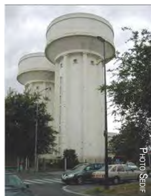
Les réservoirs aériens de Romainville (ouvrages du SEDIF)
