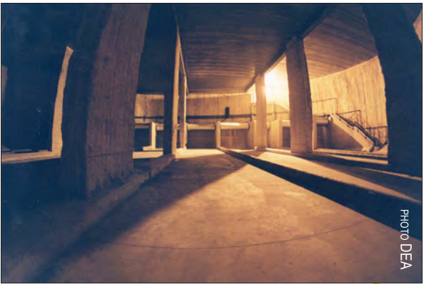
Bassin Mare aux Poutres à Sevrans (bassin enterré puis stade inondable)
