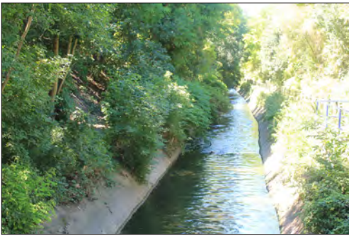
La Vieille Mer en amont du parc Georges Valbon (Dugny)
