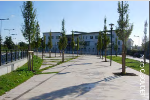
Parvis du collège Lucie Aubrac à Villeta- neuse, géré par Plaine-Commune. Les eaux pluviales sont gérées dans la noue et une partie du parvis est inondable.
