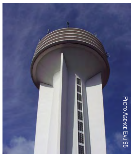
Le réservoir d'eau potable d'Arnouville
