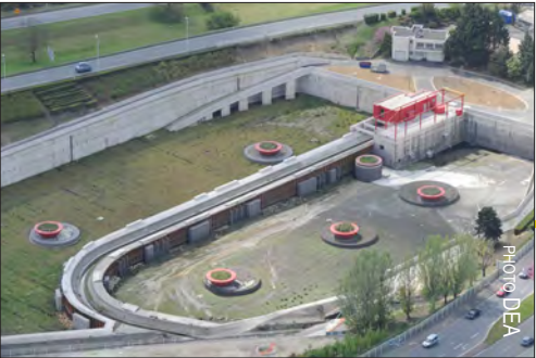
Bassin d'approfondissement du Blanc-Mesnil
