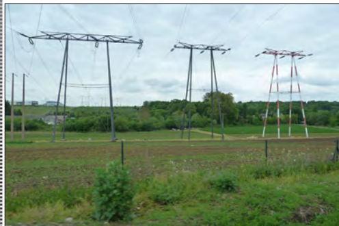
En bordure du bois d'Amour, le contexte paysager est marqué par des zones de maraîchage et d'imposants pylônes électriques
