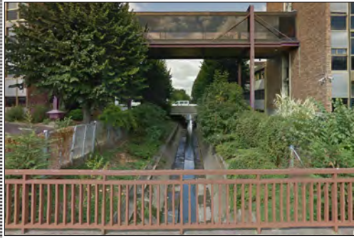
La Morée à ciel ouvert traverse la zone industrielle de Garonor à Aulnay-sous-Bois
