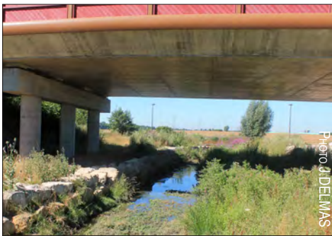
Le ru du Sausset sous le pont de la départementale
