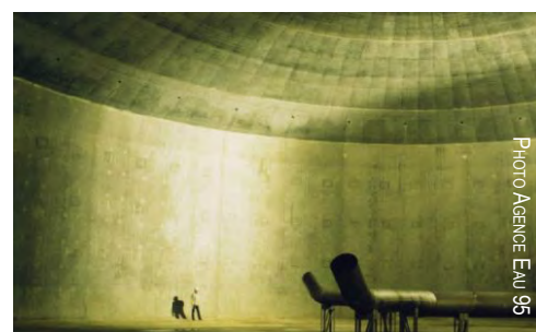
L'intérieur d'un réservoir d'eau potable en cours de vérification à Montmorency
