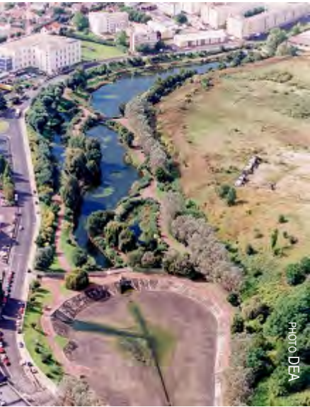
Bassin Pont Yblon au Blanc-Mesnil
